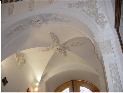
Detalle del techo con decoración barroca.
