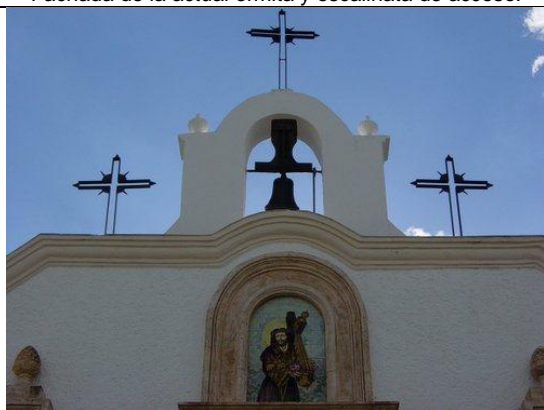
Detalle de la fachada.
