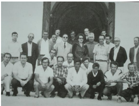
Terminación de las obras de la techumbre.
