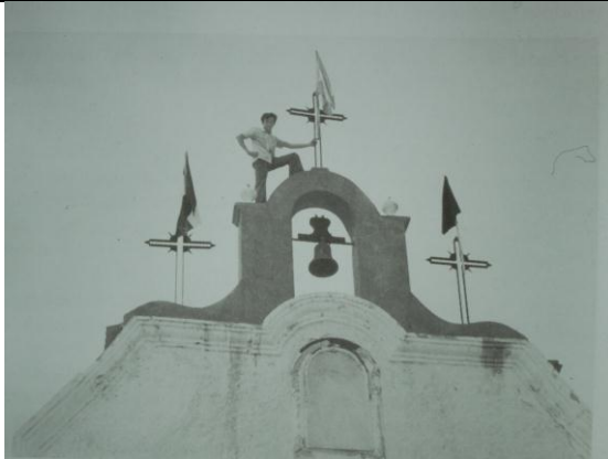
Finalización de las obras de la cubierta.
