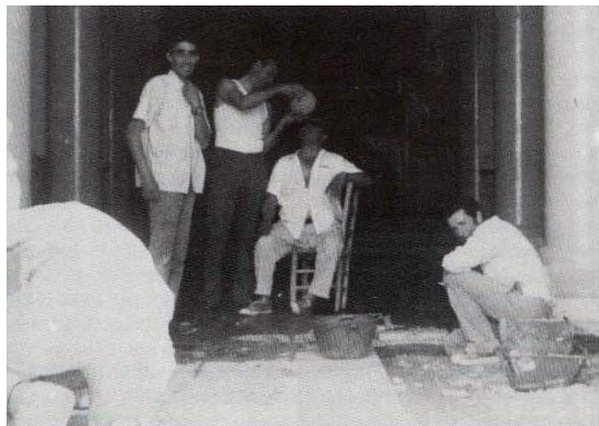
Colocando el pavimento. 1972.
