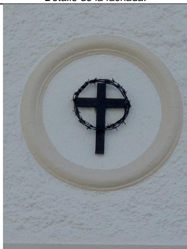
Detalle de la fachada.
